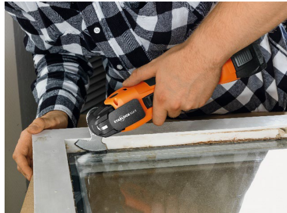
Légende : Dépose de vitres avec la lame de scie segment et le MULTIMASTER AMM 700
