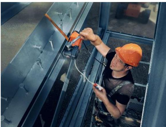
Imagen: el MAGFORCE tiene un peso total de sólo de 8,5 kg por tanto, hace que sea muy adecuado para trabajos de perforación e instalación por encima de la cabeza.
