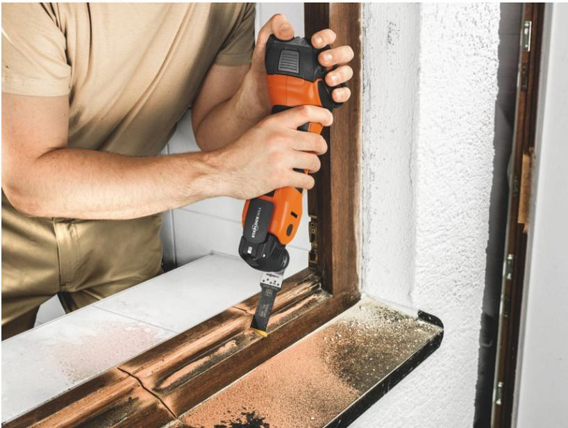
Bildunterschrift: Durch die TiN-Beschichtung weisen die BIM-TiN-Sägeblätter von FEIN eine 4x längere Lebensdauer auf.
