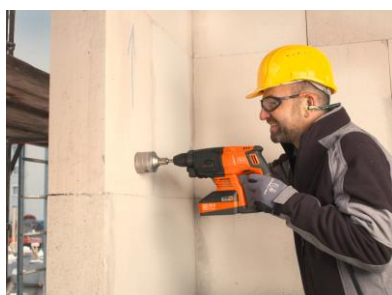
Bildunterschrift: Der Bohrhammer setzt 68-mm-Steckdosenlöcher ins Mauerwerk
