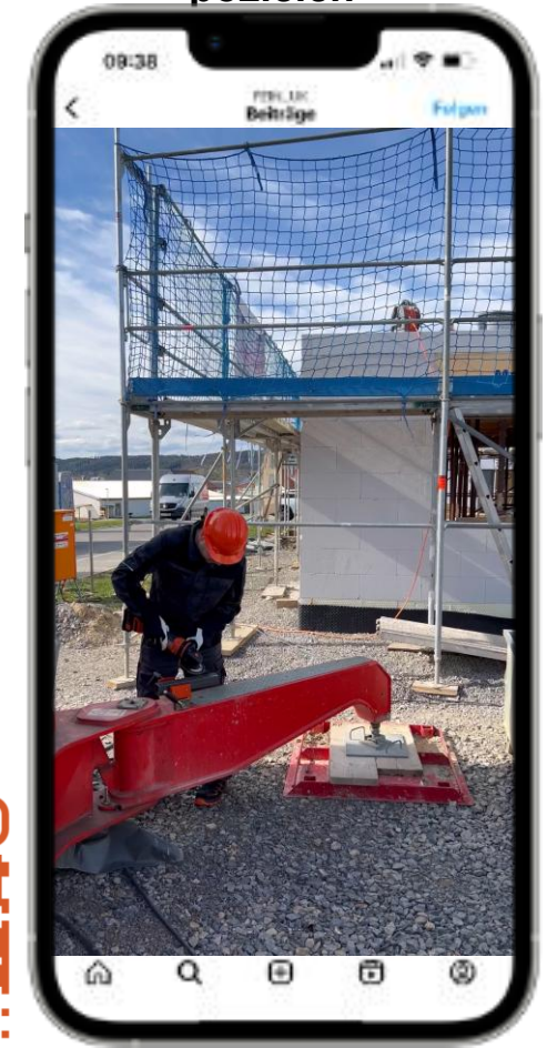
Konstrukce, práce v pozicích
