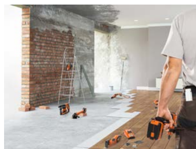
Bildunterschrift: Leistungsstarke und zuverlässige FEIN Elektrowerkzeuge im Ausbau.
