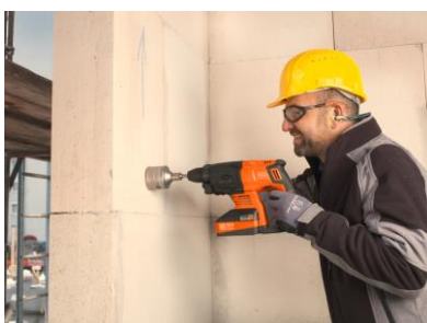
Bildunterschrift: Der Bohrhammer setzt 68-mm-Steckdosenlöcher ins Mauerwerk
