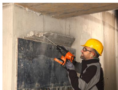
Bildunterschrift: Hohe Schlagenergie: mit dem Meißel Betonüberstände entfernen
